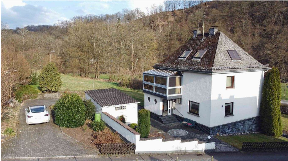
Hausrückseite mit Garagenzufahrt
